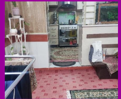
وجود سطح غیر همسطح در ورودی آشپزخانه
