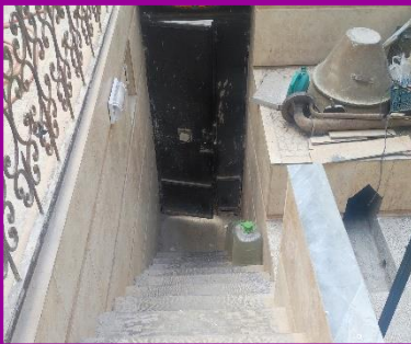
تعدد پله ها با ارتفاع نامناسب و عدم نصب میله کمکی در ورودی منزل
