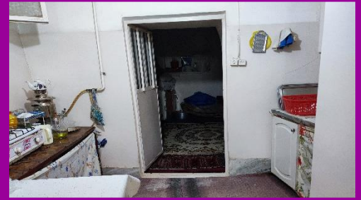
کفپوش نامناسب و لغزنده در آشپزخانه
